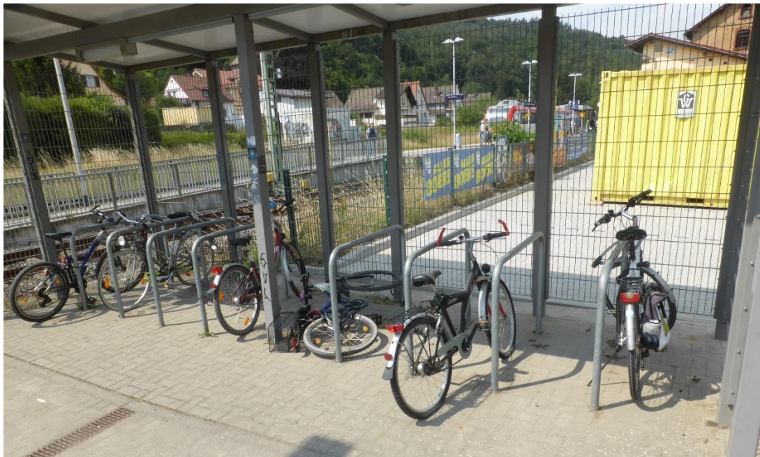
Abbildung 5: Zu dicht platzierte Fahrradbügel
