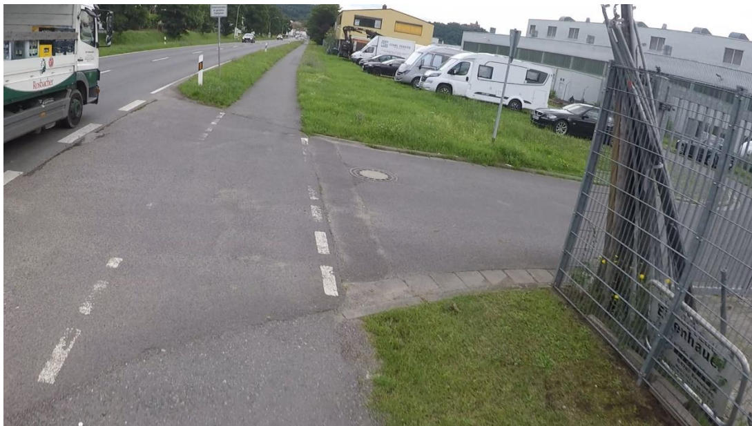
Abbildung 20: Beispiel einer zu schmalen Radverkehrsanlage mit Benutzungspflicht in Sandbach (Foto: R+T)
