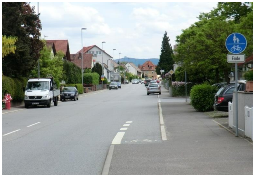
Abbildung 19: Beispiel einer markierten Ausleitung auf die Fahrbahn (Foto: R+T)
