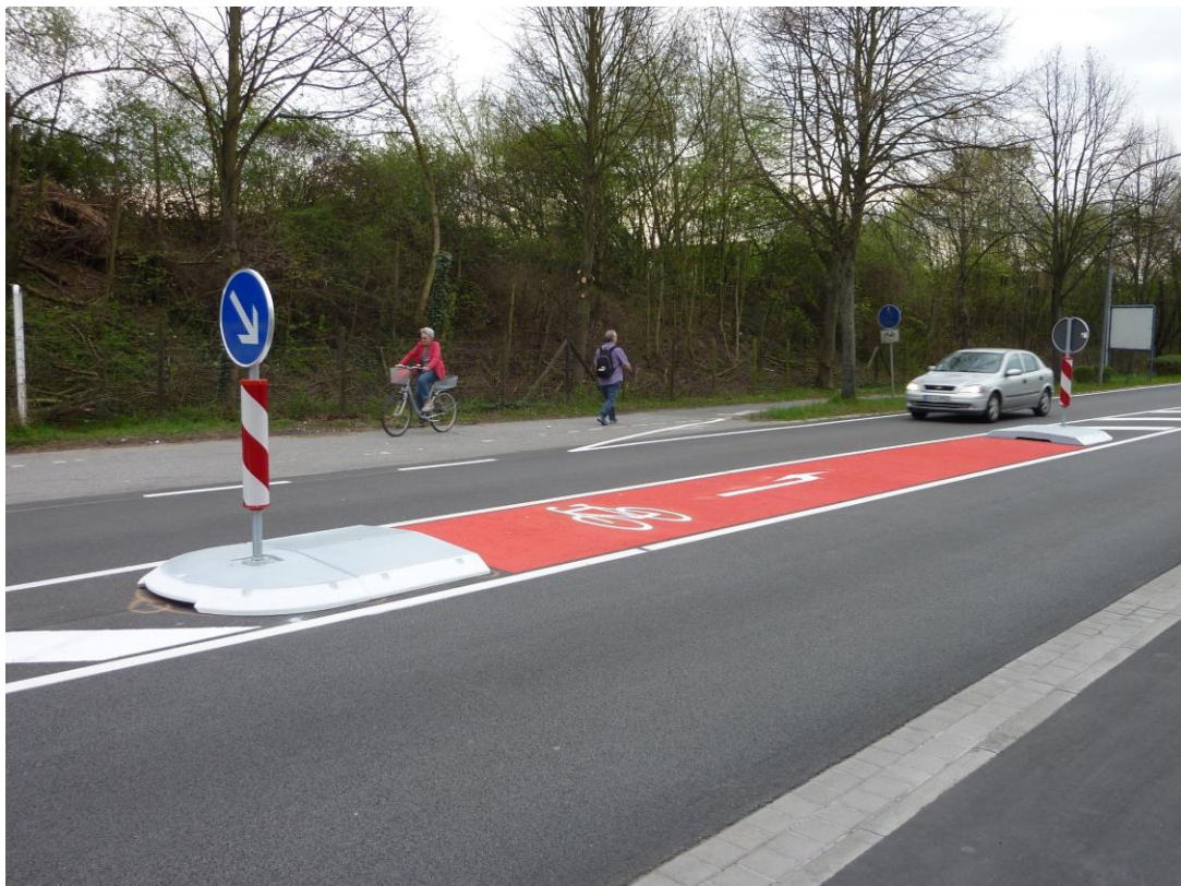
Abbildung 21: Beispiel einer Mittelinsel mit Aufstellfläche zum Linksabbiegen (Foto: R+T)
