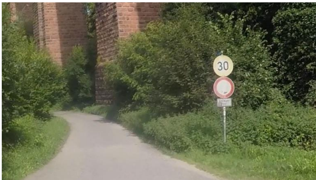
Abbildung 14: Beispiel Beschilderung Z250 (Anlieger frei) entlang des R4 am Himbächel-Viadukt (Foto: R+T)
