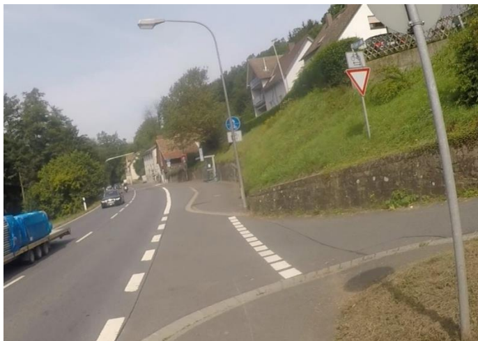
Abbildung 15: Positiv-Beispiel: Beschilderung Z205 an der B45 mit StVO-konformer Beschilderung (Foto: R+T)
