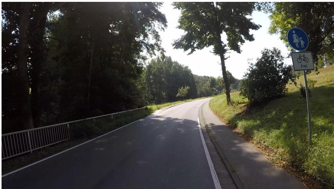
Abbildung 17: Beispiel: Beschilderung Gehweg – Rad frei in der Darmstädter Straße in Etzen-Gesäß (Foto: R+T)
